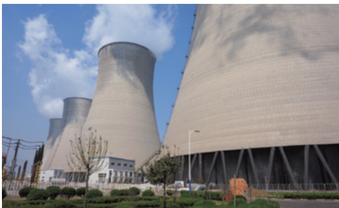
Шаньдунская электростанция Цзоупин
