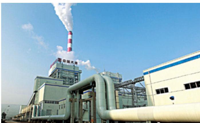
Тепловая электростанция Датанг Баоцзи
